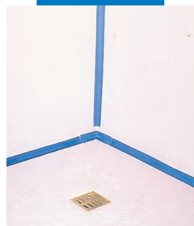
Mapegum WPS-sel és Mapeband-dal készített vízszigetelés végeredménye
