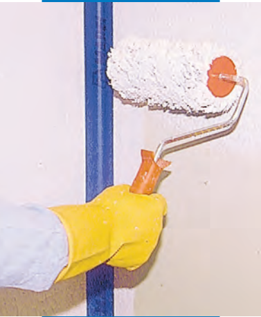
Mapegum WPS felhordása falra hengerrel
