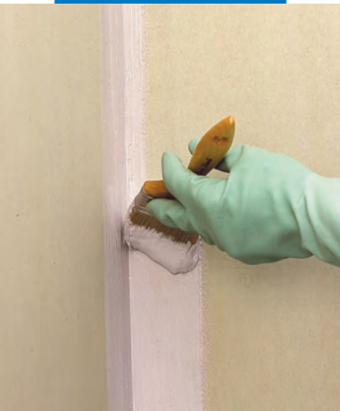
Mapegum WPS felhordása ecsettel
