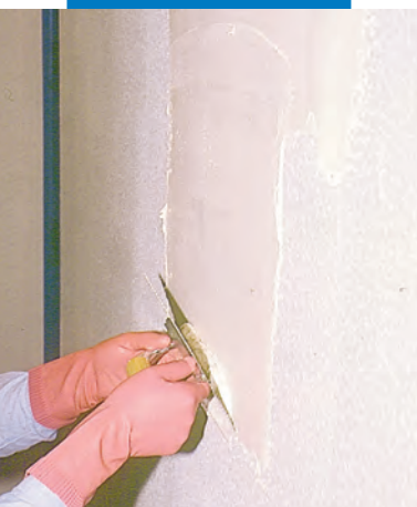
Ragasztóréteg felhordása Mapegum WPS-re
