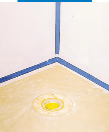
Fürdőszoba falainak vízszigetelése Mapegum WPS-sel és Mapeband-dal
