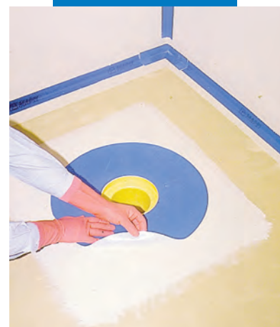
Speciális Mapeband gallér elhelyezése Mapegum WPS-re
